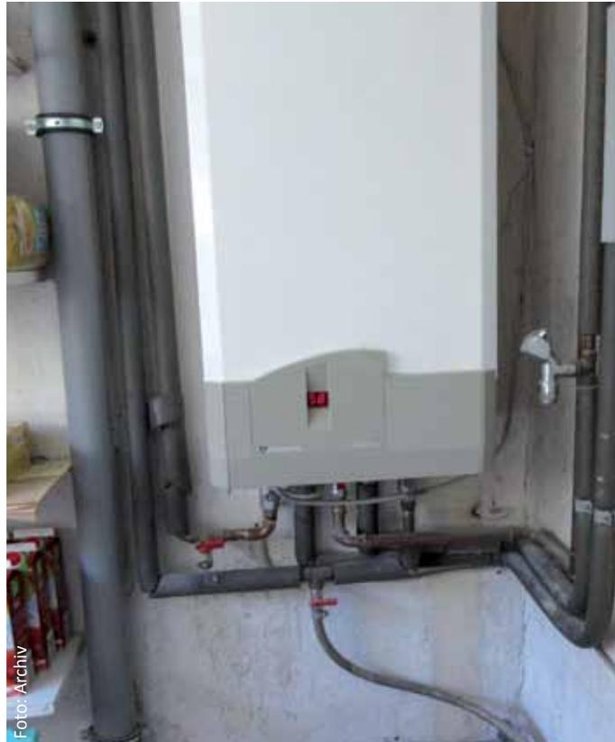
schlossen. Dabei sind Wärmemengenzähler und Ventile zur Absperrung sowie für den hydraulischen Abgleich nachzurüsten. Schließlich wird das Rohrsystem mit dem zentralen Wärmeerzeuger verbunden. Als Wärmeerzeuger kommen eine Hausanschlussstation zur Anbindung an ein Wärmenetz, eine Wärmepumpe oder Biomasseheizung beziehungsweise eine Hybridheizung infrage.
