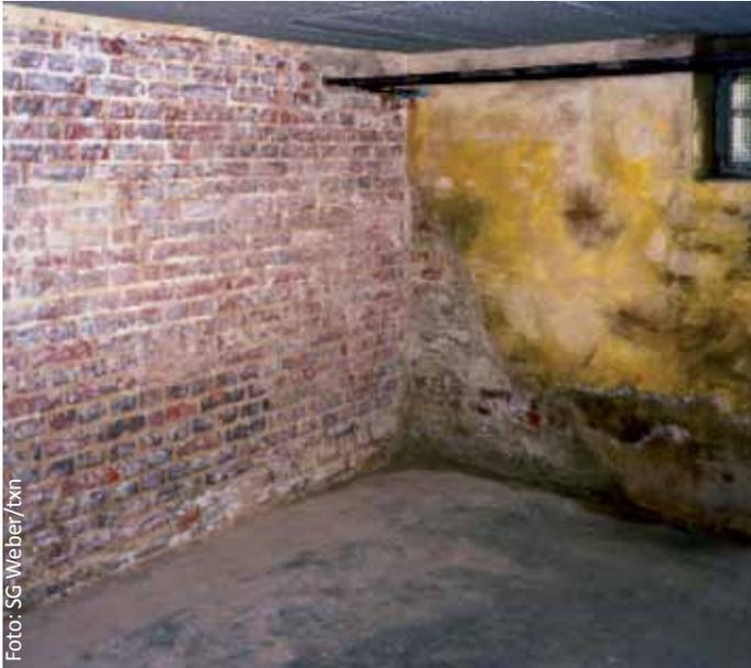
*Feuchte Keller schaden der Bausubstanz und der Gesundheit der Hausbewohner. Das Mauerwerk sollte professionell getrocknet und dann so abgedichtet werden, dass es dauerhaft vor Feuchtigkeit geschützt ist.*
