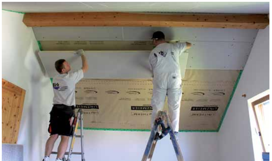
Dank des geringen Gewichts des PU-Dämmkerns ist die Installation an Decken besonders einfach.
