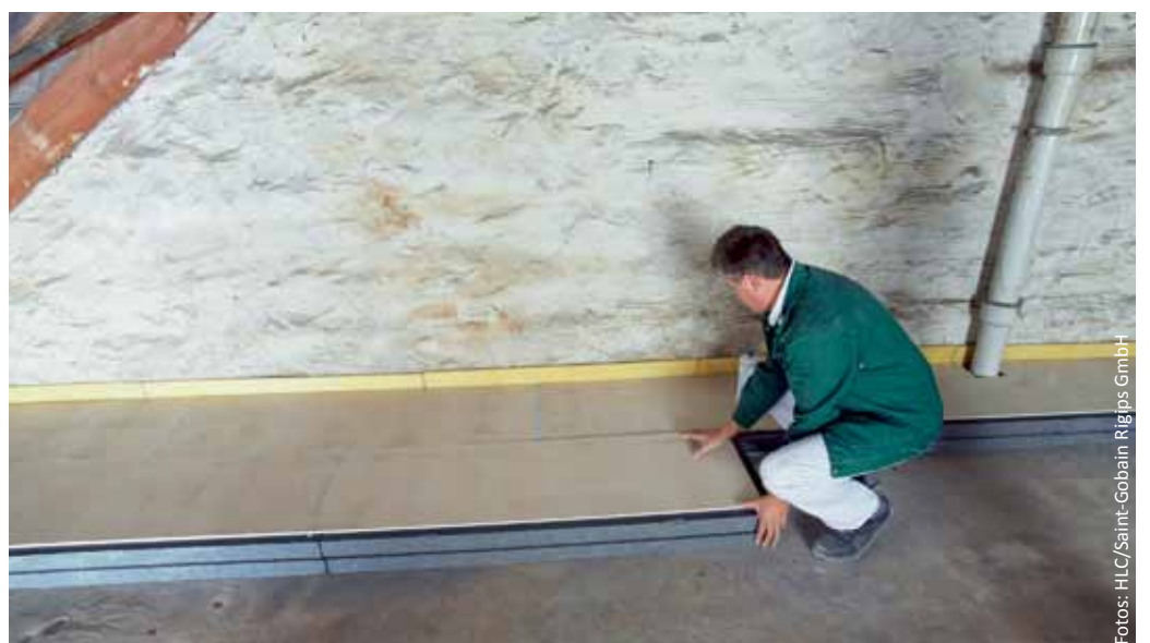
Mit wenigen Handgriffen und oft ohne Verkleben und Verschrauben entsteht mit Dachbodenelementen eine energieeffiziente, begehbare Dämmung der obersten Geschosdecke.
