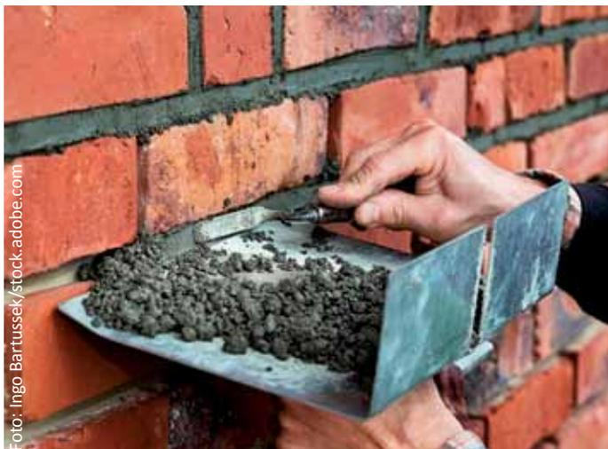
Sie neuen Mörtel auftragen, um eine feste Verbindung zu gewährleisten. Bei größeren Schäden oder komplexeren Reparaturen kann es ratsam sein, professionelle Hilfe in Anspruch zu nehmen. Ein Experte kann die Ursache von Schäden genauer diagnostizieren und die Reparaturen mit Fachkenntnissen und spezialisierten Werkzeugen durchführen.
