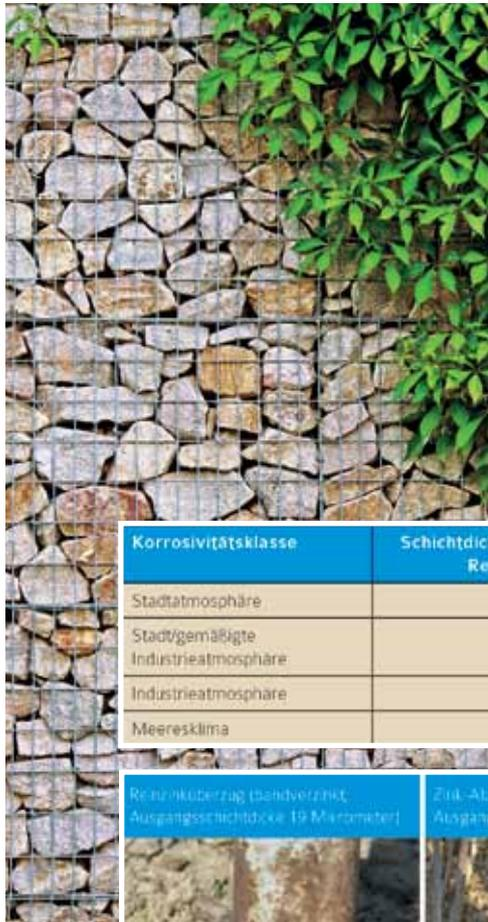
Gabionenkörbe bieten einen dauerhaften Schutz, wenn sie stückverzinkt sind.
